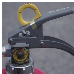
× 表示装置の脱落
