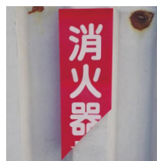
× 標識の破損
