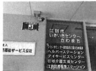
防犯カメラ設置
