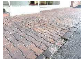
出入口インターロッキング
