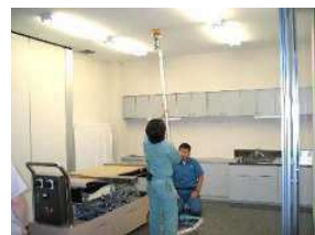
消防設備点検
