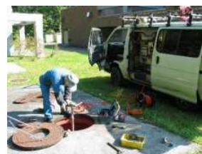
地下タンク漏洩検査
