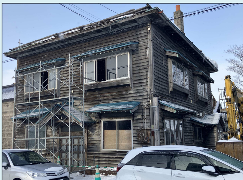
【 工事の始まった旧岡田住宅の外観 ↓ 】
