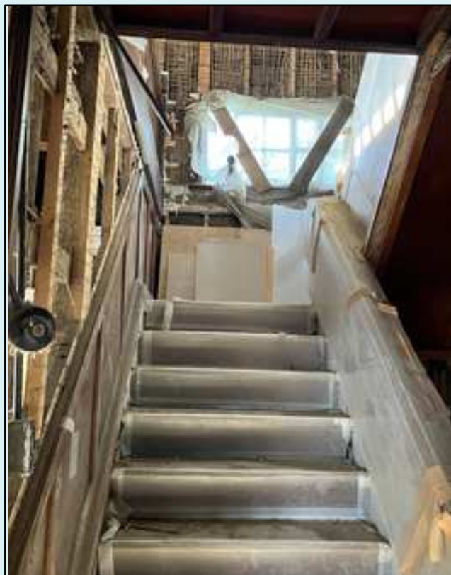
【 ↑ 再利用する階段:保護しつつ作業しています 】
