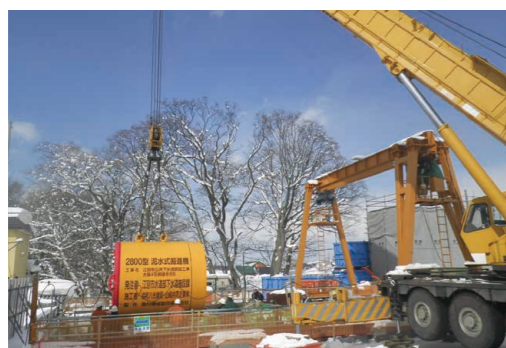
掘進機/大麻4号幹線(内径2.8m)大麻元町
