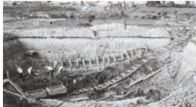
トロッコによる浄水場掘削工事
