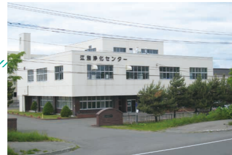
江別浄化センター 1日平均約50,000m 3 にものぼる汚水を処理しています。
