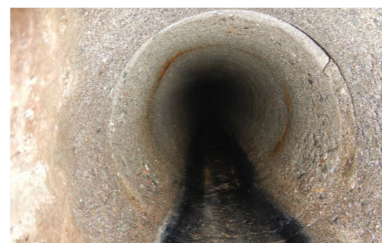
管更生前/汚水管(内径200mm)大麻西町
