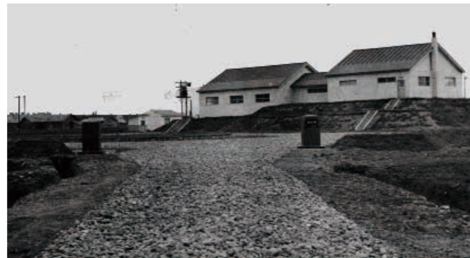
完成した浄水場(昭和31年)
