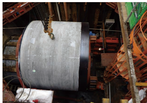
推進管/大麻4号幹線(内径2.8m)大麻元町
