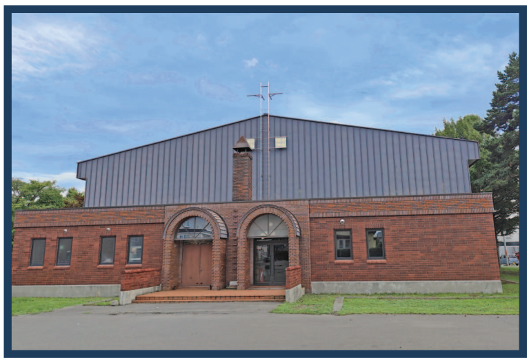
第21回江別市都市景観賞 - 建造物部門 -
