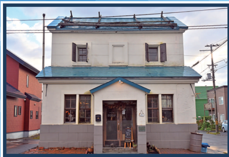
第21回江別市都市景観賞 - 建造物部門 -
