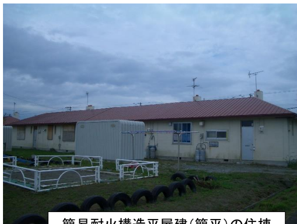
簡易耐火構造平屋建(簡平)の住棟
