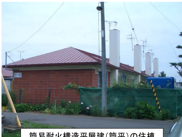
簡易耐火構造平屋建(簡平)の住棟
