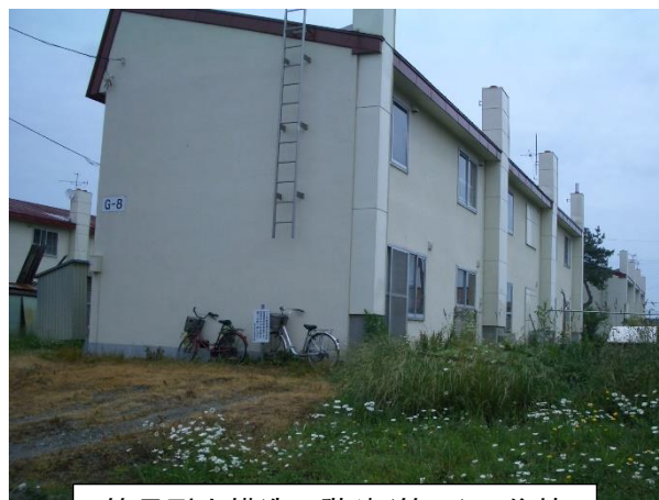
簡易耐火構造二階建(簡二)の住棟
