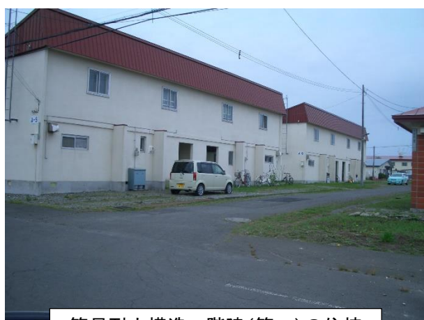
簡易耐火構造二階建(簡二)の住棟
