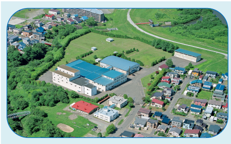
【上江別浄水場（上空より）】
