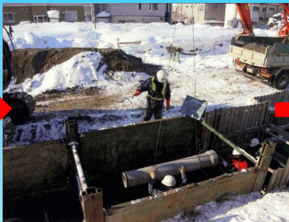
管吊り下ろし
