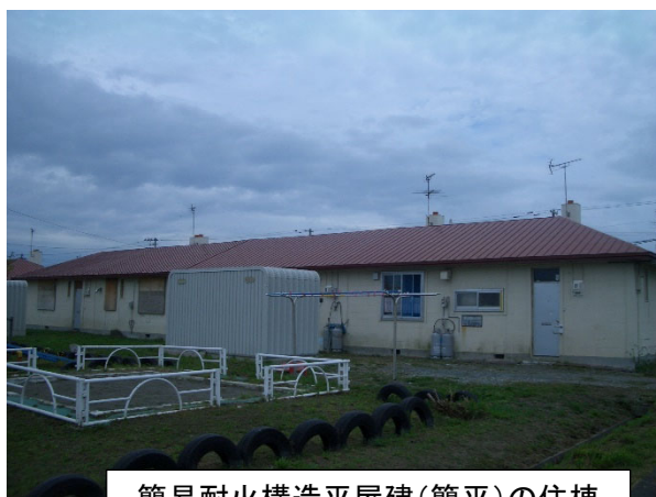
簡易耐火構造平屋建(簡平)の住棟
