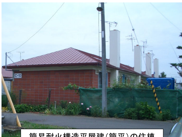
簡易耐火構造平屋建(簡平)の住棟
