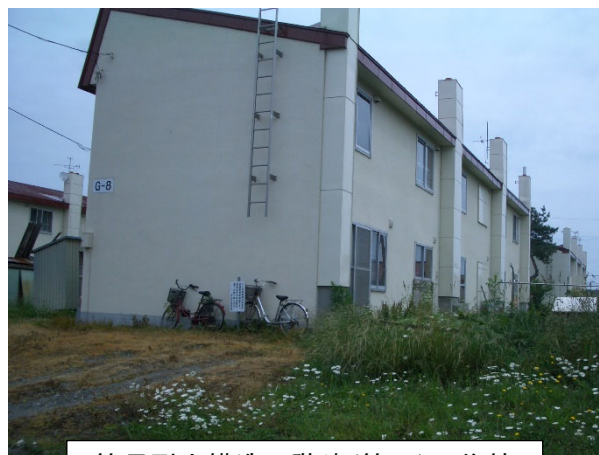
簡易耐火構造二階建(簡二)の住棟
