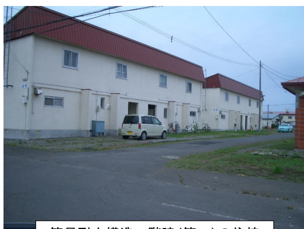
簡易耐火構造二階建(簡二)の住棟
