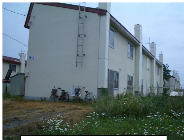
簡易耐火構造二階建(簡二)の住棟
