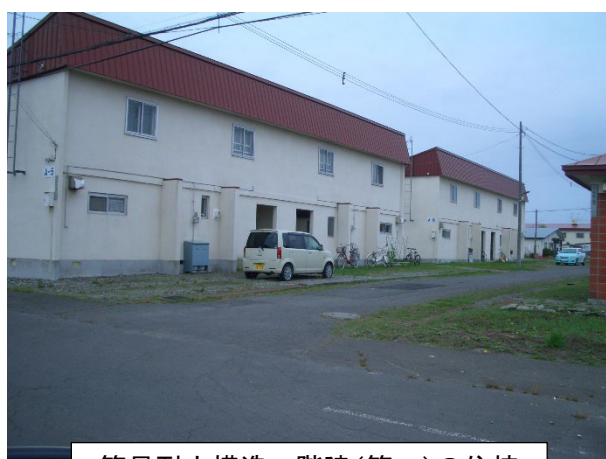
簡易耐火構造二階建(簡二)の住棟
