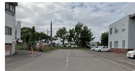
①高砂町2号道路から敷地を見る
