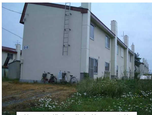
簡易耐火構造二階建(簡二)の住棟
