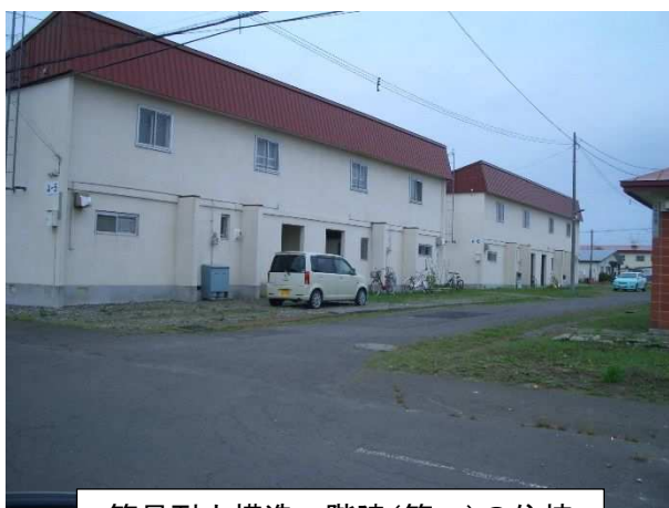
簡易耐火構造二階建(簡二)の住棟
