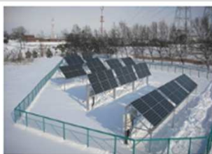
いずみ野小学校隣地
