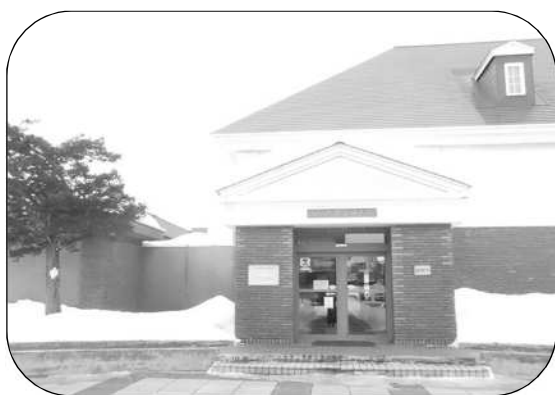
郷土資料館設備更新事業（屋上防水改修工事）
