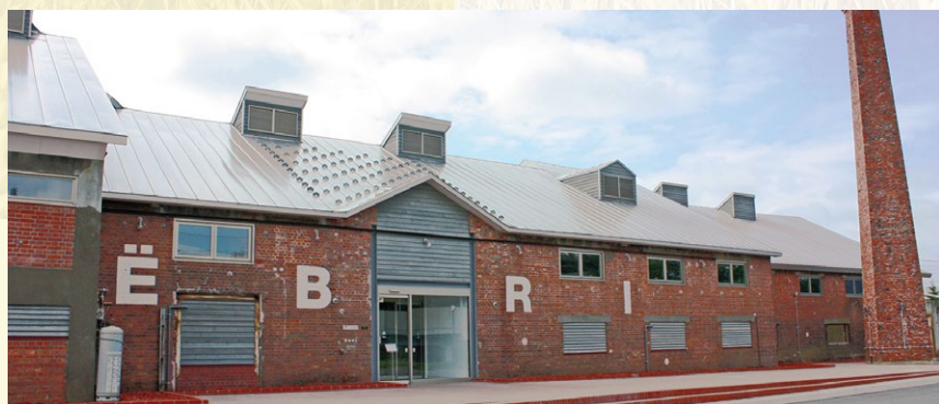
「EBRI(エブリ)」は、窯業とれんがの歴史を伝える産業遺産である旧ヒダ工場を活用した商業施設です。都市景観賞(建造物部門)にも選ばれています。
