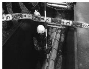
▲ 基幹管路耐震化事業
