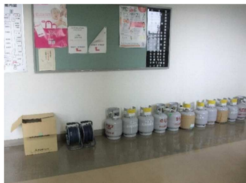
《非常時発電備蓄品の様子》
