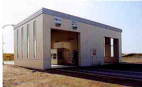
ごみ計量棟 搬入車で運ばれてきたごみを計量します。
