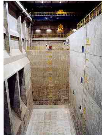
ごみピット 運び込まれたごみは一時ごみピットに貯留されます。ここにはおよそ700トンのごみを貯留できます。
