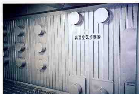
高温空気加熱器 燃焼用排ガスから熱回収を行い、熱分解の熱源となる高温空気を作り出します。
