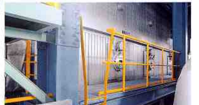
廃熱ボイラ 発電や給湯などに利用するための蒸気を作ります。
