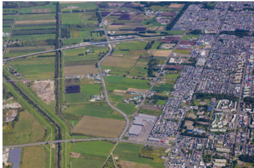
江別西インターチェンジ周辺
