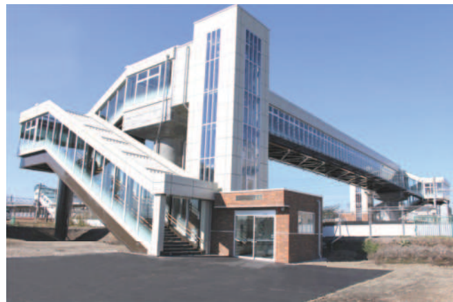
江別駅跨線人道橋
