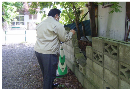
「定期パトロールの様子」
