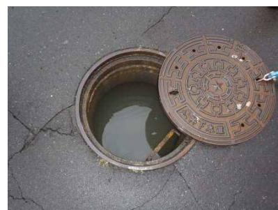
写真 3-9 【汚水管が不明水により浸った状況】
