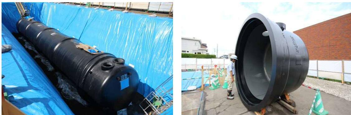
写真 7-7 [2017年度(平成29年度)に対雁小学校に設置した緊急貯水槽 100m³級]
