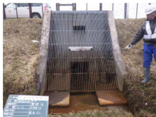
写真 7-9【雨水設備点検状況】
