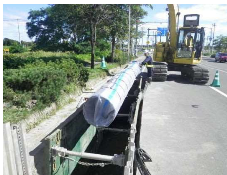
写真 5-2【管路の耐震化工事】
