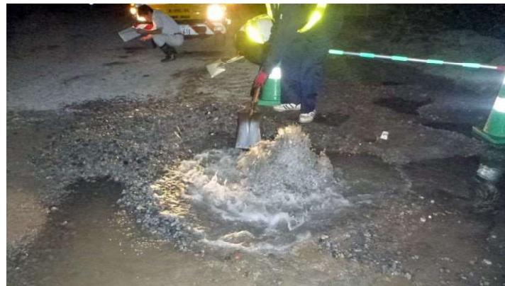
写真 3-1 【漏水が原因で地中から溢れる水道水】
