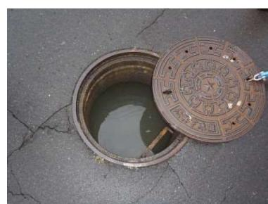
写真 3-9 【污水管が不明水により浸った状況】
