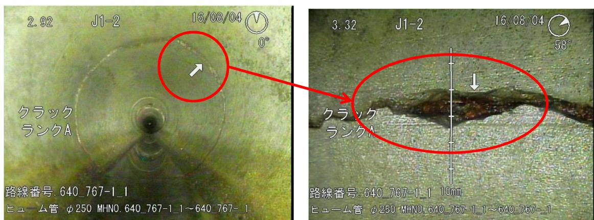
写真 3-4【管路内破損状況】
