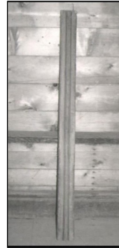
8 收藏番号1947 : 敷居 (教室入口)
