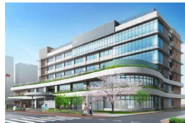
大和高田市庁舎 ZEB Ready (奈良県)
