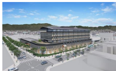
各務原市庁舎 ZEB Ready (岐阜県)
