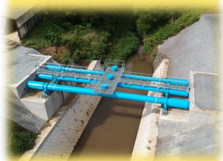
早苗別水管橋(令和 3 年度架替完成)
