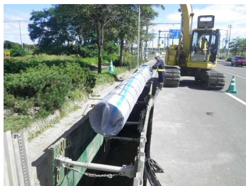
写真 5-2【管路の耐震化工事】
