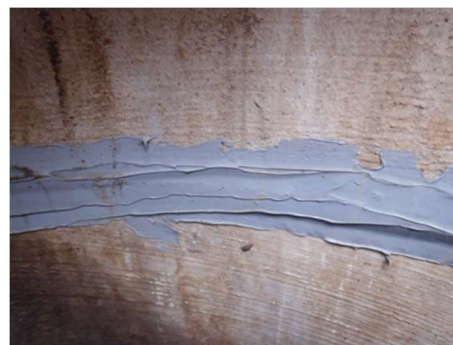
写真 7-5【マンホール内継目補修状況】
