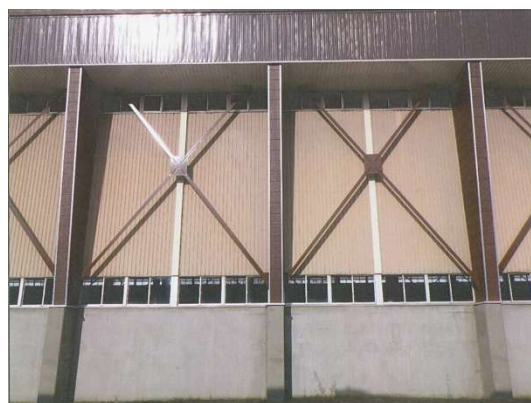
写真 7-6【合流系池棟の耐震化 対策前（左）補強部材設置後（右）】
