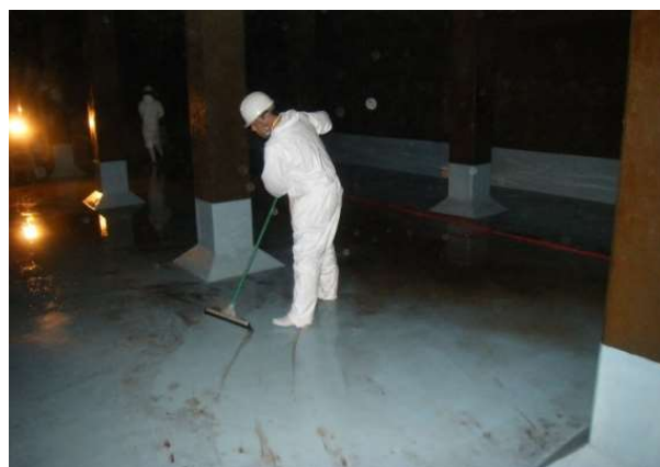
写真 7-3【配水池内部の清掃】
