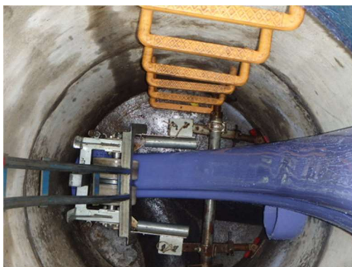
写真 7-12【更生管の引き込み状況（左）と管更生工事後（右）】
