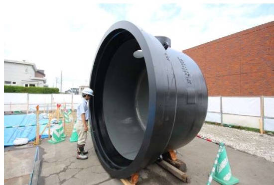
写真 7-7 【2017（平成 29）年度に対雁小学校に設置した緊急貯水槽 100 m級】
