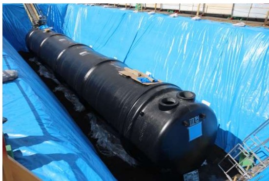
写真 7-7 【2017（平成 29）年度に対雁小学校に設置した緊急貯水槽 100 m級】
