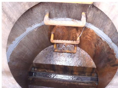
写真 7-5【マンホール内継目補修状況】
