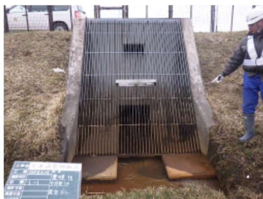
写真 7-9【雨水設備点検状況】
