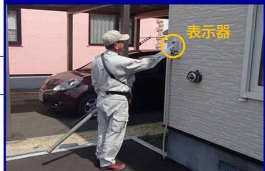
壁面に設置された表示器で検針
