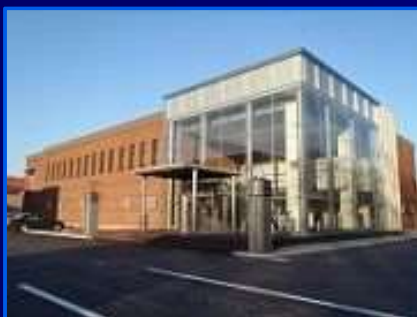
【千歳川浄水場】
