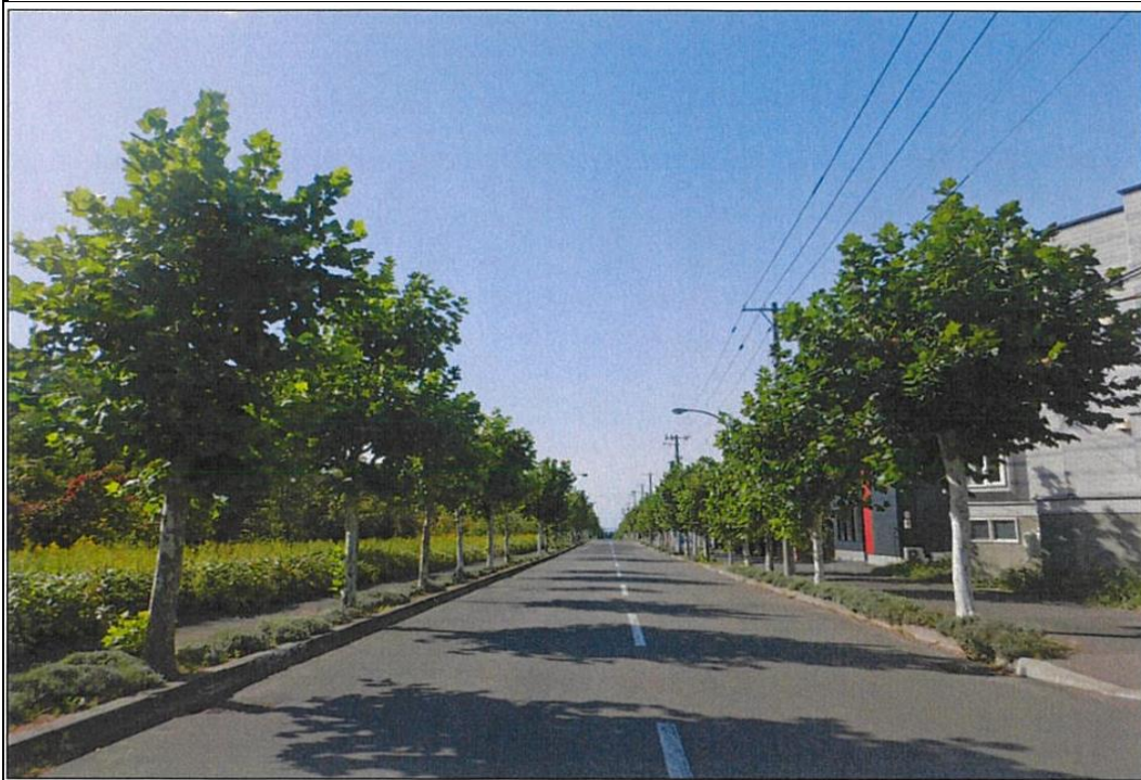
事業実施前の状況
