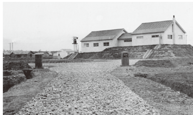
完成した浄水場(昭和31年)
