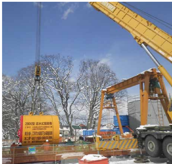
掘進機/大麻4号幹線(内径2.8m)大麻元町
