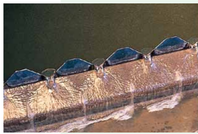
最終沈殿池 反応槽で増殖した活性汚泥を底に沈め、きれいになったうわ水を滅菌処理してから河川に流します。沈んだ泥は汚泥処理施設へ送られます。
