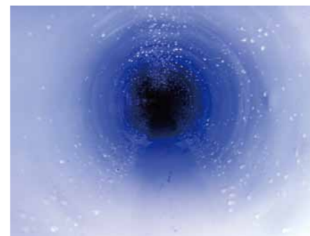
管更生後/汚水管(内径200mm)大麻西町
