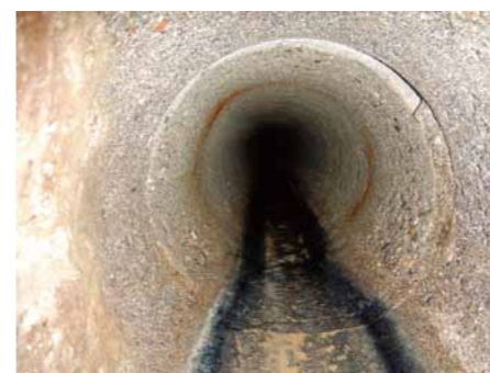
管更生前/汚水管(内径200mm)大麻西町
