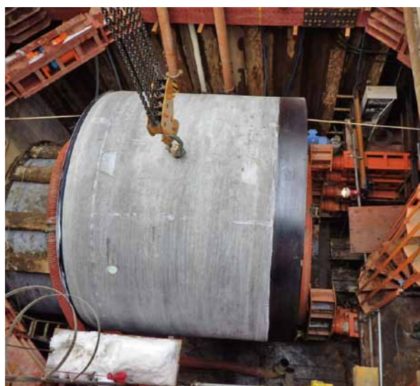
推進管/大麻4号幹線(内径2.8m)大麻元町
