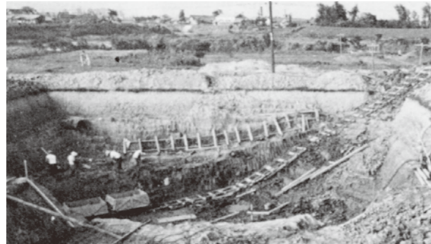
トロックによる浄水場掘削工事
