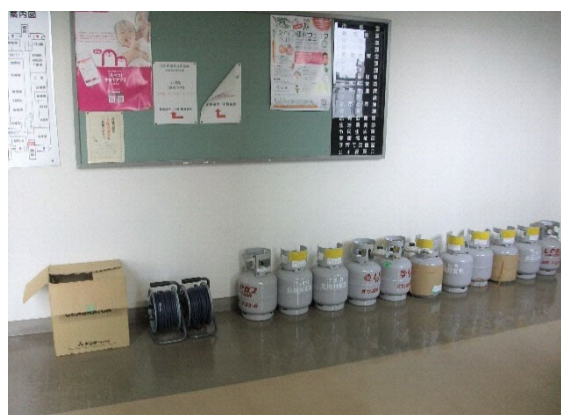
〈非常時発電備蓄品の様子〉
