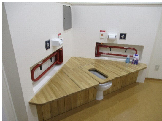
〈多機能トイレの例(釧路市防災庁舎)〉
