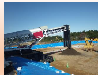
中間貯蔵施設 土壌貯蔵施設
