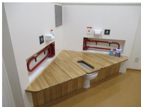
〈多機能トイレの例(釧路市防災庁舎)〉
