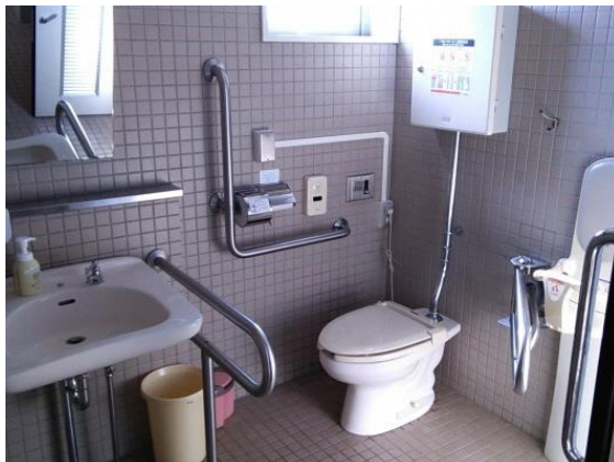
<多目的トイレ>
