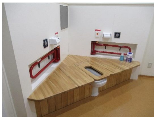
〈多機能トイレの例(釧路市防災庁舎)〉
