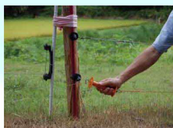
侵入防止柵の設置
