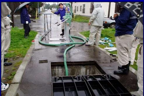
地震などで配水管が破損したときは、貯水槽と配水管をつなぐバルブが自動的に遮断され、緊急時の飲料水が確保されます。平常時は配水管として新鮮な水が流れています。
