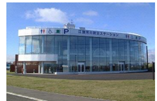
河川防災ステーション
