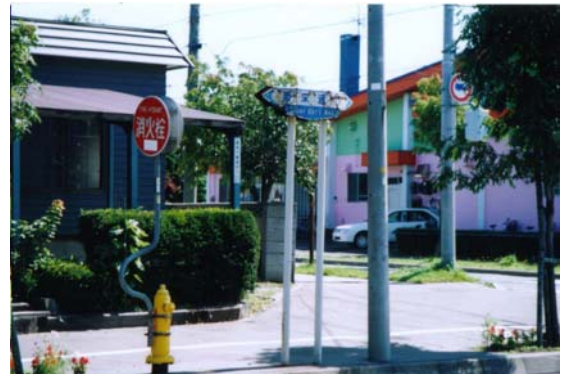
傷んだ道路標識
