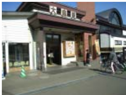
【大麻駅北口・南口】
