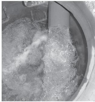
市では、きれいな水道水をお使いいただくため、約9.29kmある市内の水道管を8つの区域に分け、8年周期で洗管作業を行っています。作業は左の写真のように、水道管に大量の水道水を流して、濁りの原因となる水あかを取り除きます。
