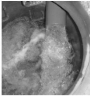
市では、きれいな水道水をお使いいただくため、約9.29kmある市内の水道管を8つの区域に分け、8年周期で洗管作業を行っています。作業は左の写真のように、水道管に大量の水道水を流して、濁りの原因となる水あかを取り除きます。この作業を行うことで、折損事故の漏水など、急激に水量が増えた場合でも、水道水が濁ることはありません。
