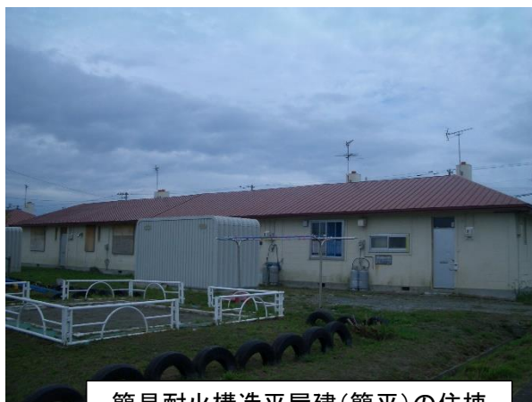
簡易耐火構造平屋建(簡平)の住棟
