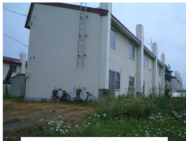
簡易耐火構造二階建(簡二)の住棟
