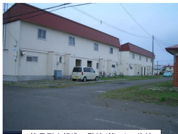
簡易耐火構造二階建(簡二)の住棟
