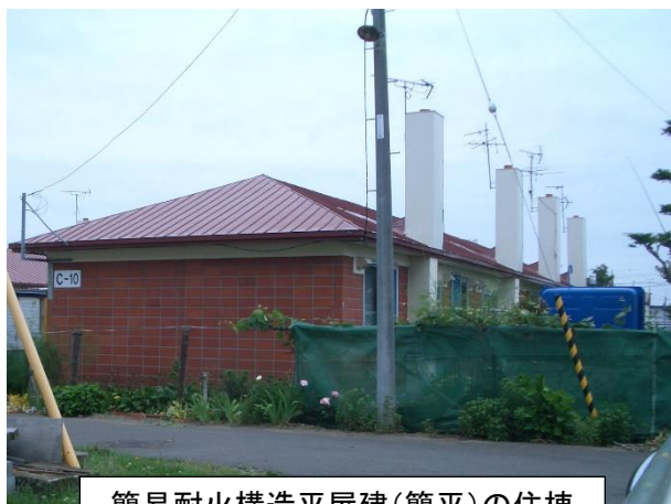
簡易耐火構造平屋建(簡平)の住棟
