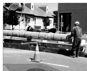
▲ 基幹管路耐震化事業
