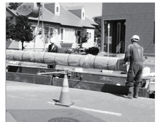
▲ 基幹管路耐震化事業
