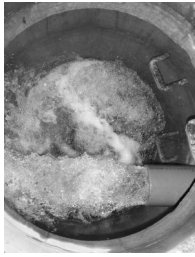
▲ 洗管作業で大量の水を流している様子
