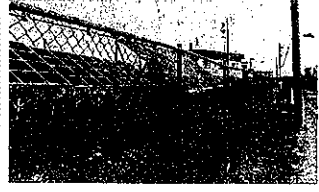
住宅地に設置されたソーラーパネル
