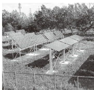
いずみ野小学校の太陽光発電システム
