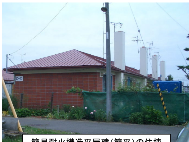
簡易耐火構造平屋建(簡平)の住棟
