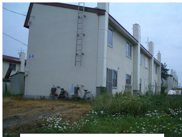
簡易耐火構造二階建(簡二)の住棟
