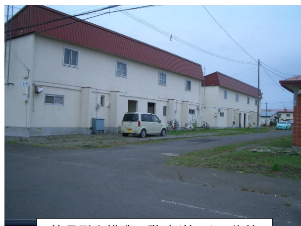
簡易耐火構造二階建(簡二)の住棟
