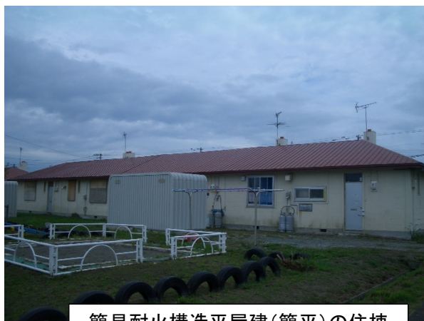
簡易耐火構造平屋建(簡平)の住棟
