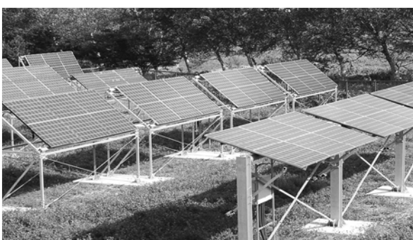
いずみ野小学校の太陽光発電システム
